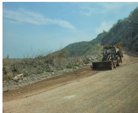
รูปที่ 3.7-1 การปรับปรุงสภาพทางขนส่งแร่ให้สามารถใช้งานได้
