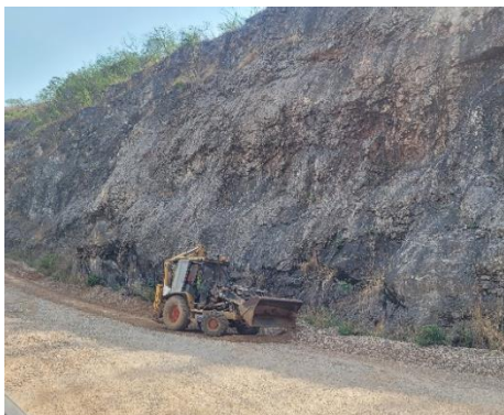
รูปที่ 3.7-1 การปรับปรุงสภาพทางขนส่งแร่ให้สามารถใช้งานได้
